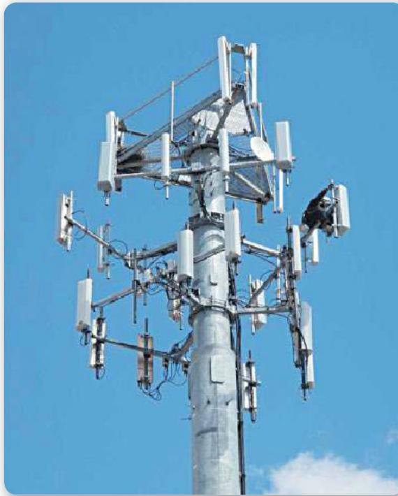
**Figura 20.** Un ejemplo de una antena de telefonía móvil. Estas antenas son las encargadas de distribuir las señales provenientes de equipos celulares.
